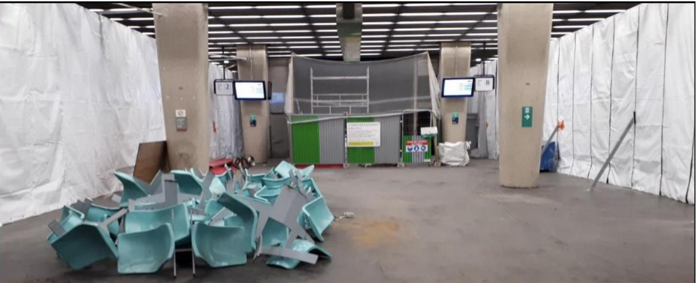
*Un exemple de bâches acoustiques installées par un de nos clients dans le RER A sur une dimension de 42 m de long et 4 m de hauteur.*
